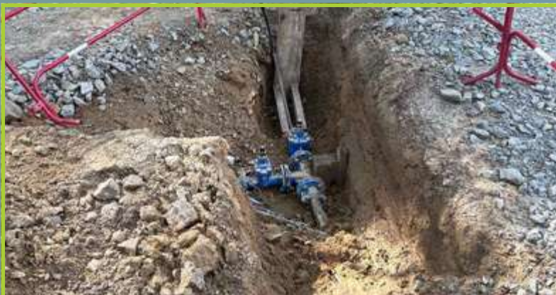
Eau : réhabilitation du réseau d'eau P.7
